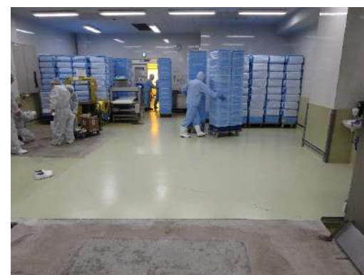
床面補修後の状態
