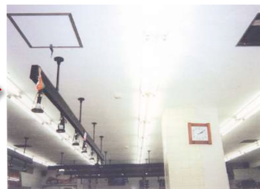
防カビ塗装完了後の状態
