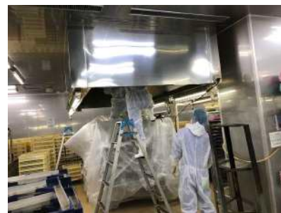
ダクト・空調機機の分解洗浄
