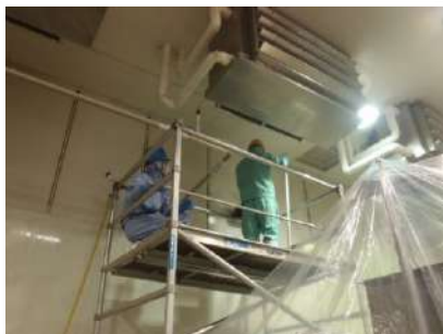
高所壁面の洗浄・殺菌
