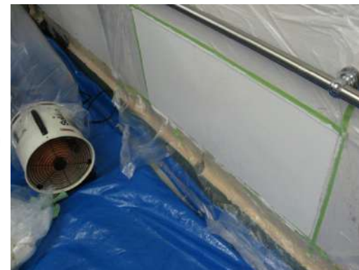
コーティング終了後の状態
