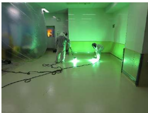
UVコーティングによる床面補修
