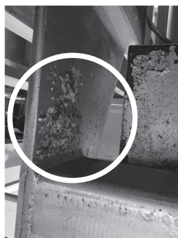
写真3 機械のフレーム裏側に残渣が堆積している様子
