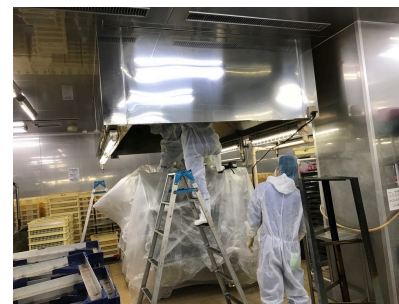
ダクト・空調機機の分解洗浄
