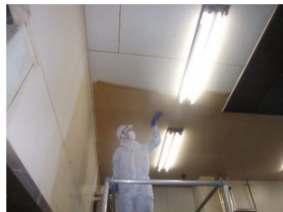
天井面・空調機具の洗浄・カビ除去・殺菌
