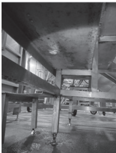
写真2 作業台裏側の汚染が拡大している
