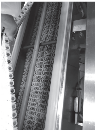
写真1 コンベア内側に堆積した汚染
